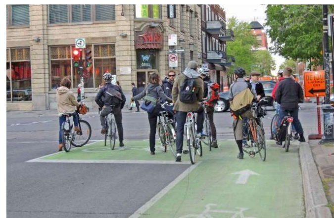
Exemples de sas vélo et de cédez le passage cycliste au feu
