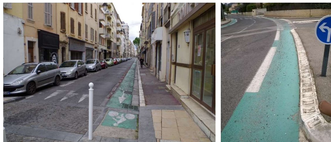
Exemples de tronçons cyclables avec un revêtement dégradé à mettre à niveau
